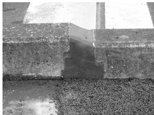
(b) 橋台位置の桁端部と背面の段差
