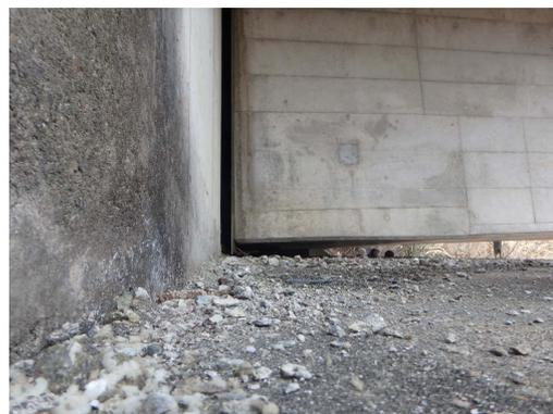
(c) 右岸側橋台の橋座位置の桁の浮き(橋台沈下)
