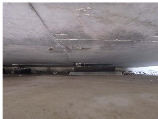
(d) 右岸側橋台の橋座位置での桁の浮き(橋台沈下)
