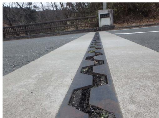
(a) 伸縮装置の橋軸方向開き
