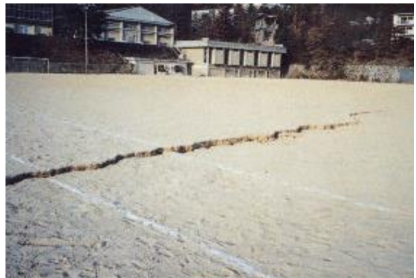
図-2 兵庫県南部地震時にグラウンドに現れた亀裂
