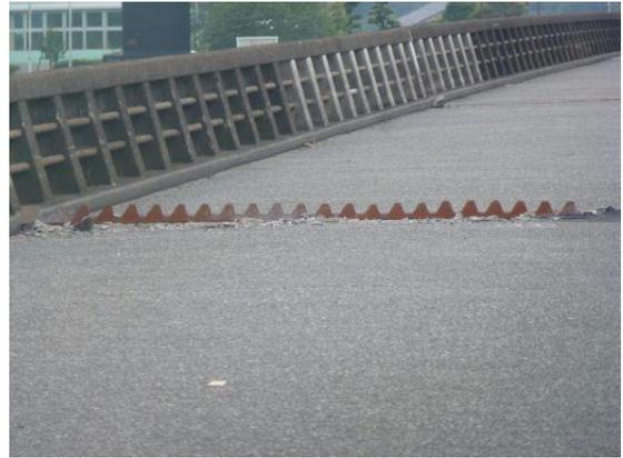
(b)伸縮装置の損傷
