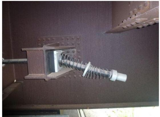
(b)落橋防止ケーブルの塑性変形
