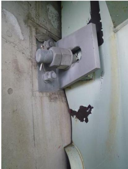
(c)桁端と橋台バラベットの衝突
