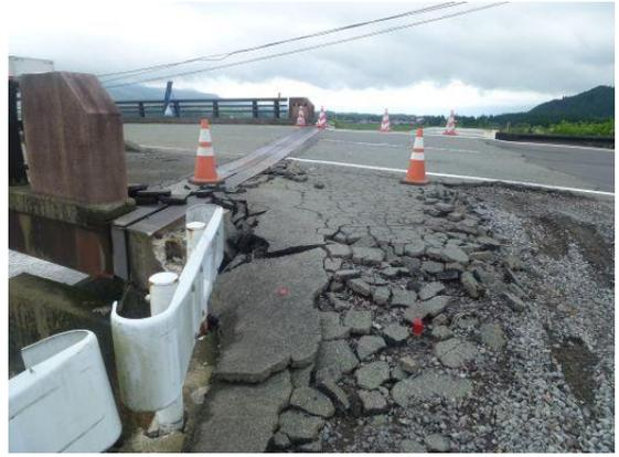
(a)左岸側橋台の損傷
