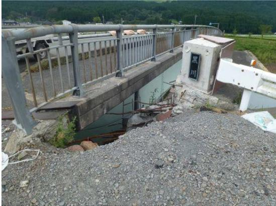
(b)左岸側橋台の損傷
