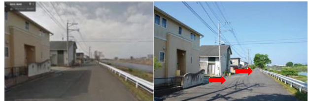
写真-2 地震前後の家屋の様子(不同沈下)
