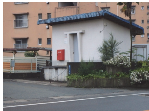
図-1 液状化による小規模構造物の沈下・傾斜
