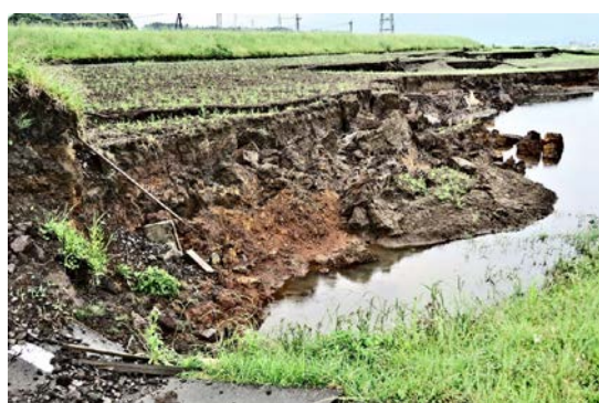
写真-2 着目した水田地帯周辺の震災直後の様子
