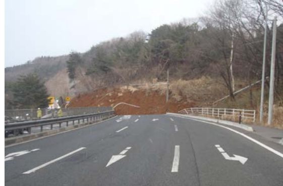
図-6 上から、排土作業中の全景、4号線北側、4号線南側の被害直後の様子、日本大学中村晋教授提供
