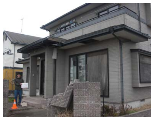
写真-1 常時微動計測状況の一例(石巻市街地内)
