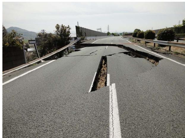
写真-1 秋津川橋の橋台部の高速道路盛土の被災状況
