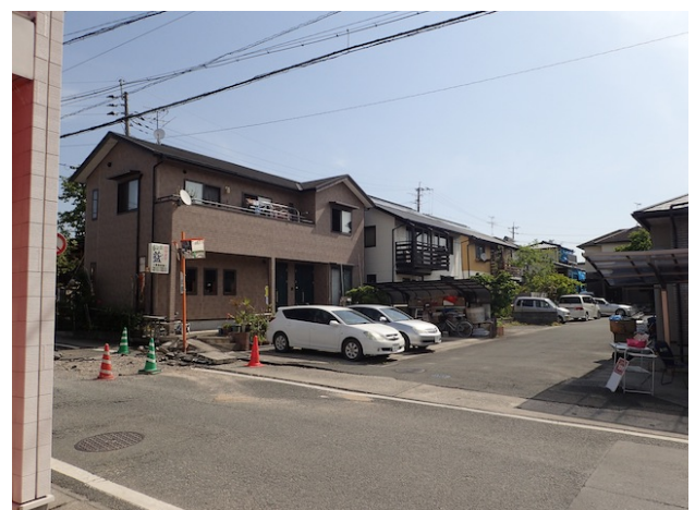
写真-3 益城町中心部で地表地震断層とされている付近の様子
