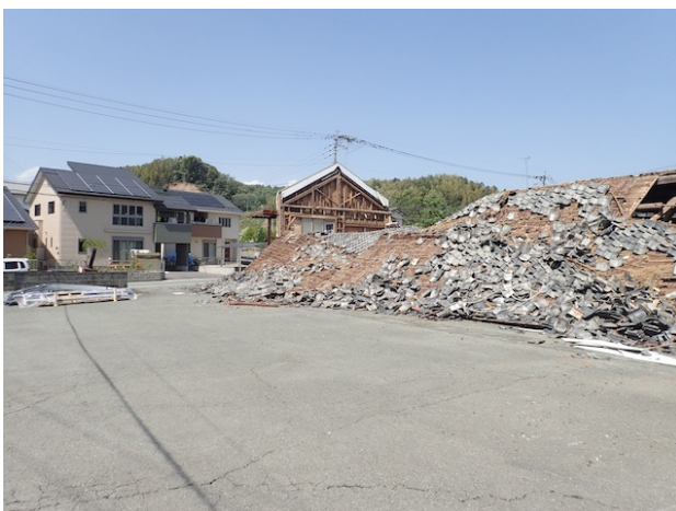
写真-2 益城町田原における木造建築の倒壊
