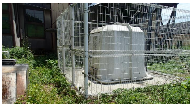
図-13 KMM009 観測点の設置状況
