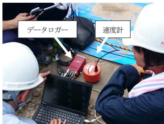
図-5 振動計測状況
