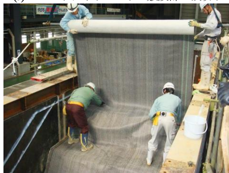
(b) ベントナイトシートの敷設
