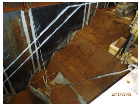
(a) ベントナイトシートの敷設部の段切り
