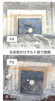
写真-6 大切畑大橋のゴム支承の破断と桁逸脱
