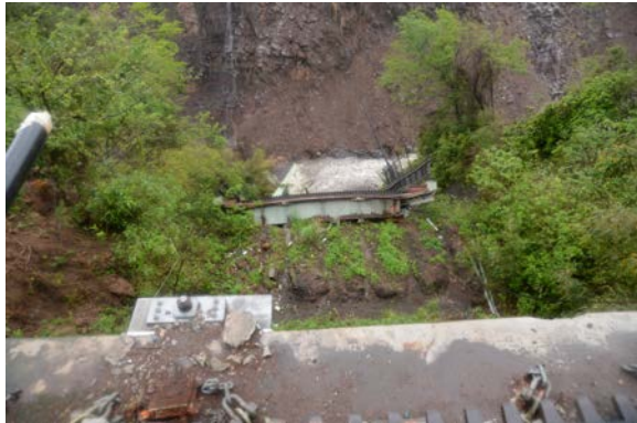
写真-13 流出した阿蘇大橋の桁部
