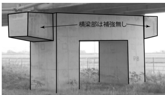
図-6 木山川橋橋脚の耐震補強状況
