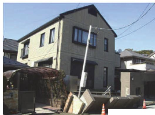
写真-3 浦安市で液状化により被災した住宅
