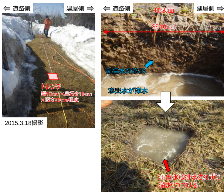
図-8 トレンチからの融雪水の滲出状況
