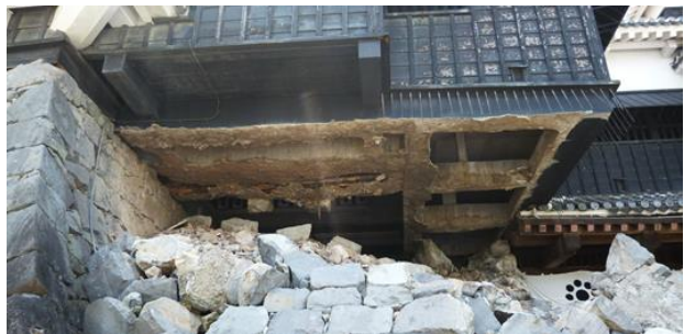
写真11 天守の基礎部分のRC梁
