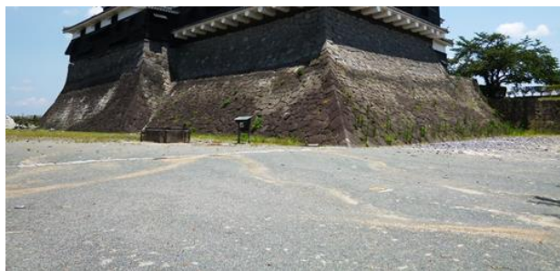
写真 12 天守周辺地盤の凹凸現象
