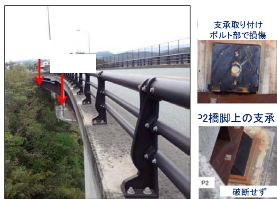
(a) P1～P2 橋脚区間
