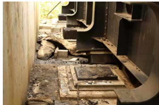
(b) 主桁～パラペット(胸壁)間
