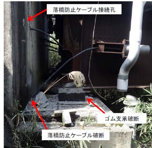
(a) 橋台部側面
