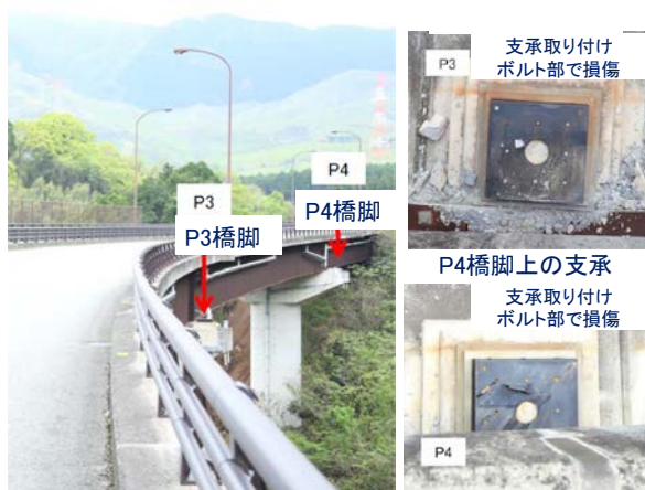
(b) P3～P4 橋脚区間
