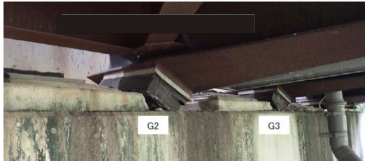
(a) 桁下 (支承部)
