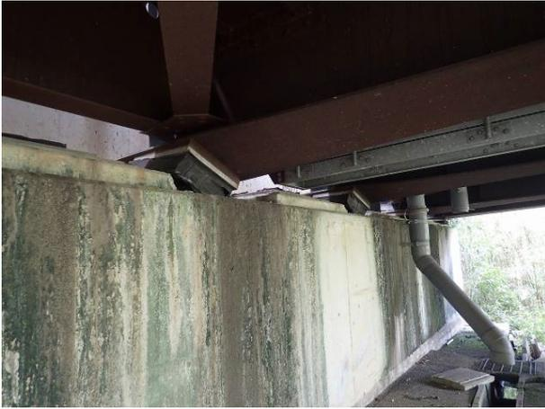
写真-1 大切畑大橋西端の被害状況。橋桁の橋軸直交方向への移動と支承からの落下、ゴム支承の破断等の被害が見られる (32°50'33"N, 130°55'38"E)
