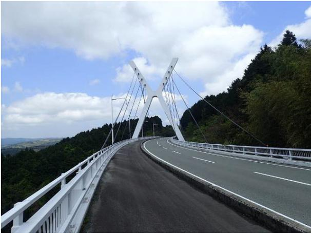
写真-3 南西方向から見た桑鶴大橋の全景。橋桁は写真左方向に大きく変位 (32°51'04"N, 130°56'43"E)
