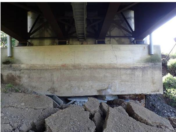
写真-5 俵山大橋西端の橋台の被害状況。橋台全面の地盤は崩落し、基礎頭部が露出 (32°51'48"N, 130°57'47"E)
