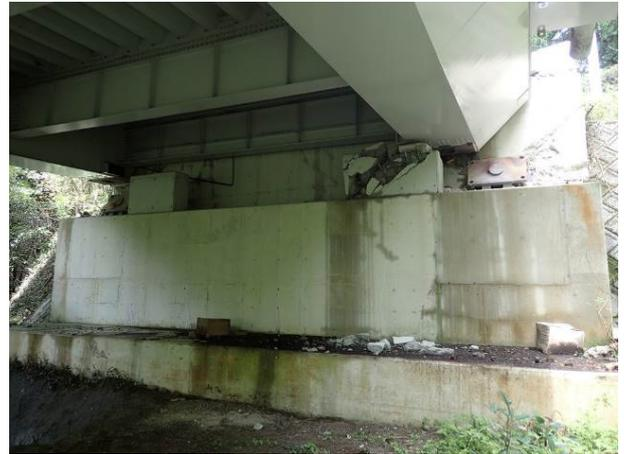
写真-4 桑鶴大橋北東端の被害状況。橋桁の橋台への衝突と軸直交方向への変位等の被害が見られる (32°51'07"N, 130°56'48"E)
