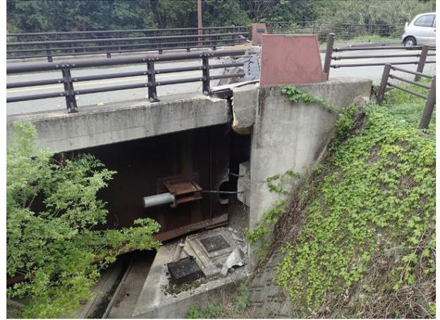
写真-2 大切畑大橋東端の被害状況。橋桁の橋台への衝突、橋軸直交方向への移動と支承からの落下、ゴム支承の破断等の被害が見られる (32°50'32"N, 130°55'47"E)
