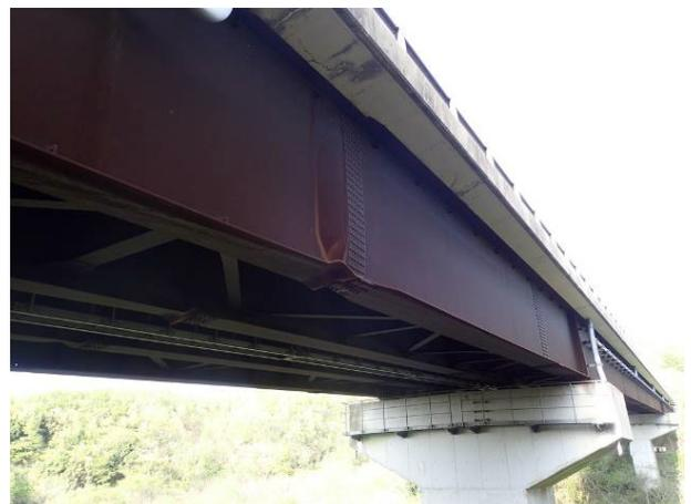
写真-6 俵山大橋の鋼製桁の座屈被害状況 (32°51'46"N, 130°57'37"E)
