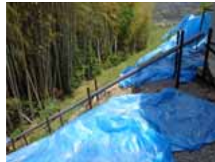
①地盤変位計の設置
