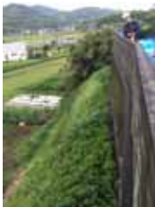
③L型擁壁の傾斜 ④亀裂上のビニールシート敷設
