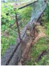
①ブロック積み擁壁の変状 ②宅地内の段差
