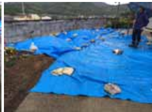
③L型擁壁の傾斜 ④亀裂上のビニールシート敷設
