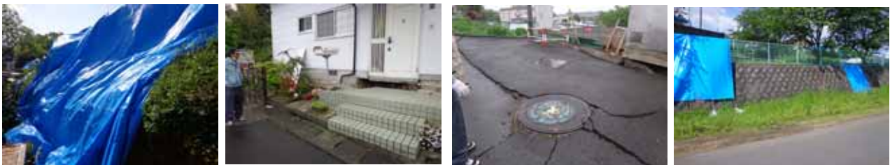
(b)ー2 被害状況写真
