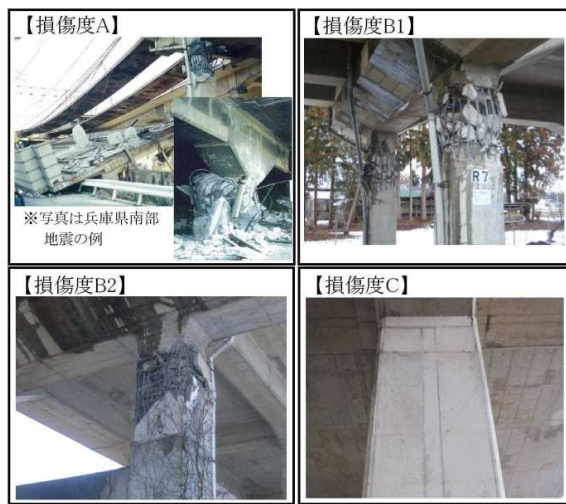
図-3 損傷度の判定区分の例
