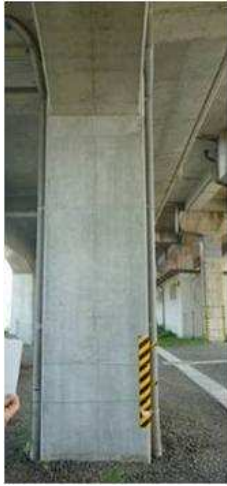
図-5 新耐震基準で設計されたRC高架橋柱の損傷状況例
