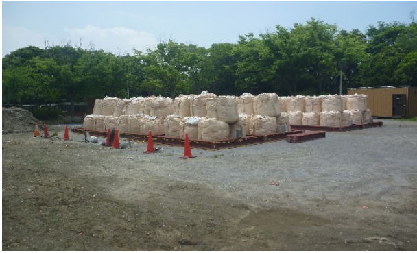
写真-2 現地施工状況
