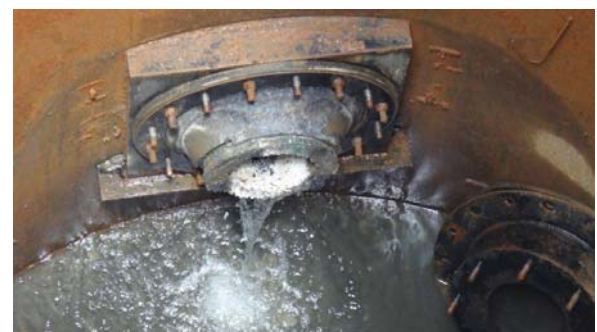
写真-8 推進工法による地下水位の排水状況
