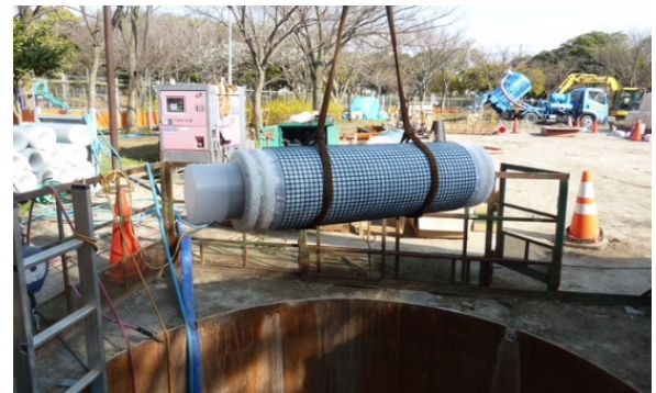
写真-7 推進工の施工状況
