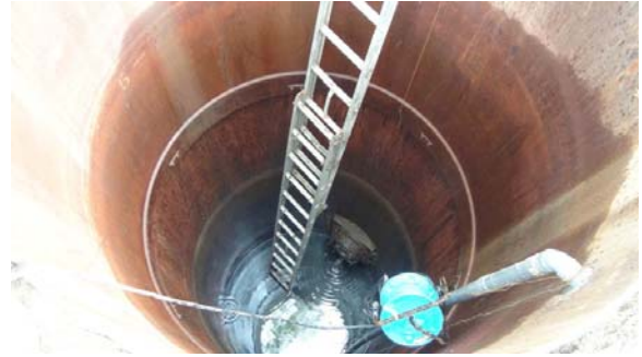
写真-5 立坑の設置状況
