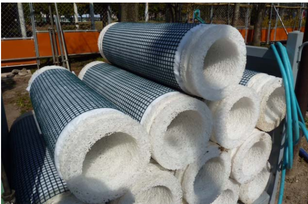
写真-4 推進暗渠管 (挿入前, MP ドレーンに透水シート, ジオテキスタイルを巻いた状況)
