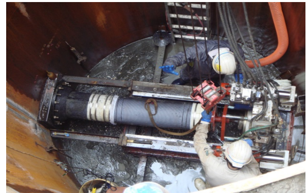
写真-6 推進管の施工状況
