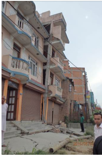
写真3 Araniko Highway 周辺の傾斜した中層構造物
