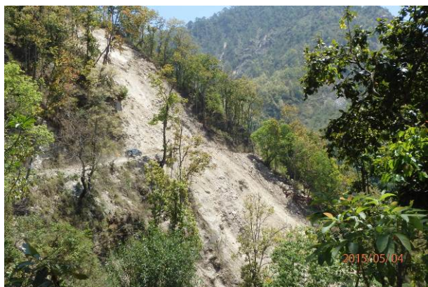
写真7 大規模な表層崩壊（震源の南西約5km）
