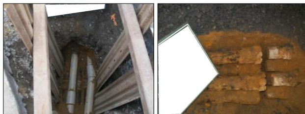
図 1 コンクリート巻き立て箇所付近の管路被害
