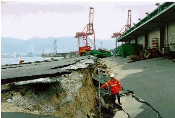
図-12 兵庫県南部地震における重力式岸壁の被害事例
