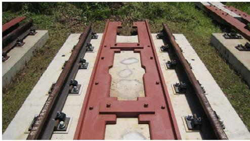
図4 逸脱防止装置の例
