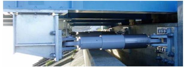
写真-3 ダンパーの設置状況 (提供：東北地方整備局)
