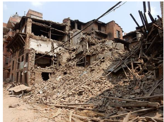
写真-6.2 粉々になった倒壊建物
