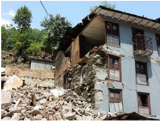
写真-6.3 倒壊を免れた建物も石積の建物
