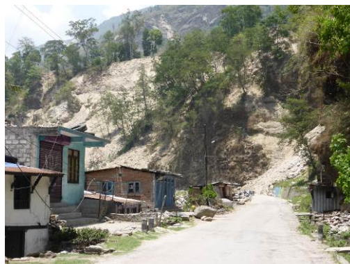
写真-3.6 表層崩壊の一例
