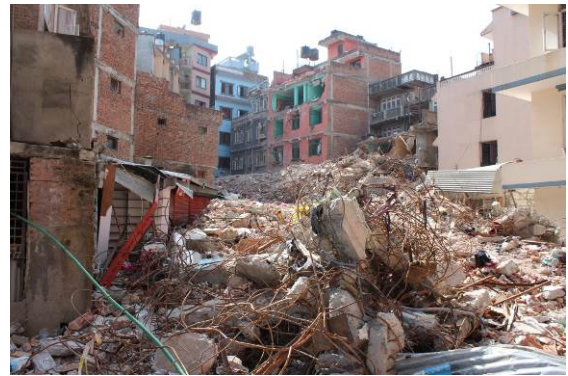
写真-6.1 倒壊して瓦礫と化した柱・梁構造の建物
