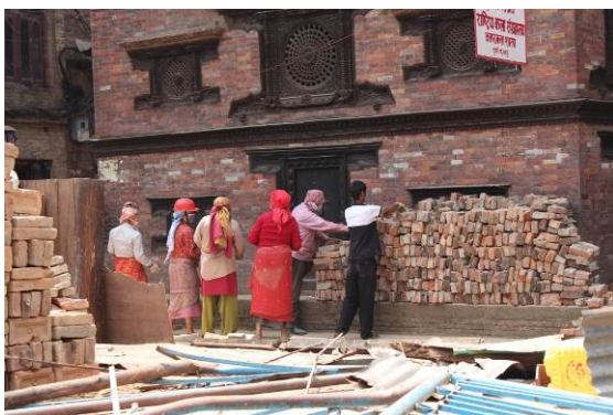
写真-6.5 崩れた建物のれんがの整理
