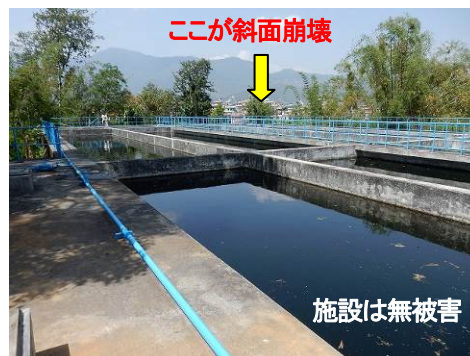
写真4.1 バンスバリ浄水場沈澱池
