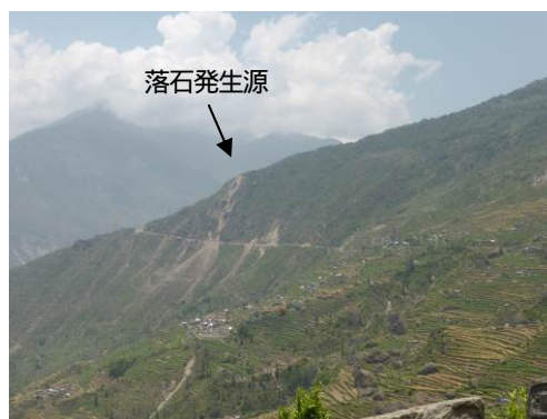
写真-3.4 落石の一例
