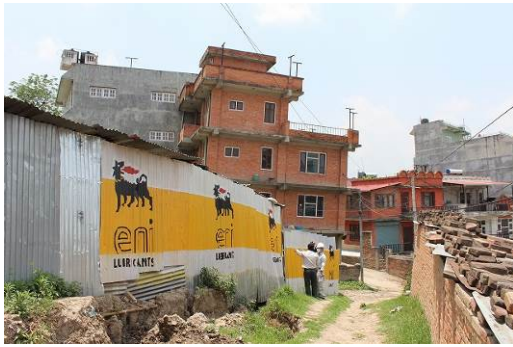
写真-5.3 道路南側の住宅地における地盤の段差
