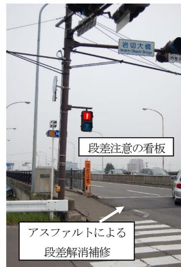
写真-1 橋台背面地盤沈下に伴う段差障害の例
