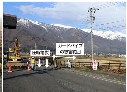
(c)道路の圧縮亀裂とガードパイプの被害(亀裂部分は北城断層通過位置)
