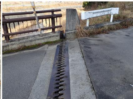
(e)橋梁の桁の移動(河川堤防および橋梁支承に被害)
