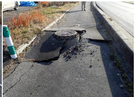
(f)液状化によるマンホールの浮上(ライフラインの埋戻土の液状化)
