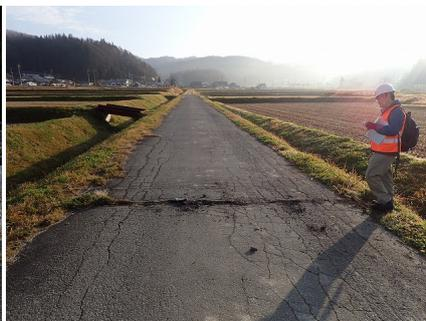
(b)道路の圧縮亀裂(同様の被害は三日市場地区、堀之内地区に多数確認)
