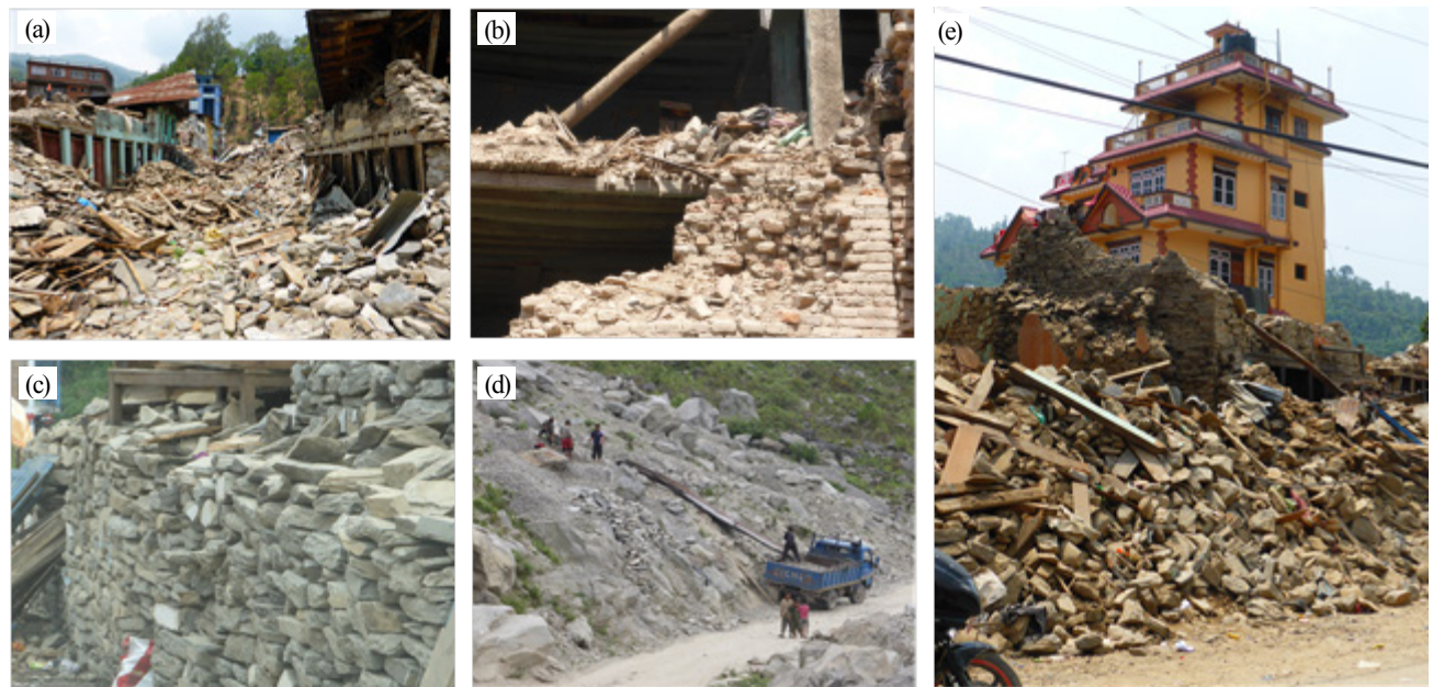
図-3 組積造構造物の崩壊事例 ((d)は斜面から石を採取している様子)
