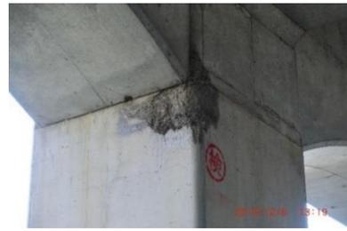
図-10 東北地方太平洋沖地震による対象高架橋のかぶりコンクリートの剥離 (2013年12月著者撮影)
