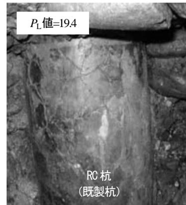
図-10 杭頭部の損傷状況
