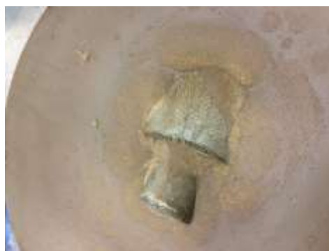
図-11 上部型重量化工法を適用したマンホール の回転 (上 : 45° ほど回転、下 90° ほど回転)
