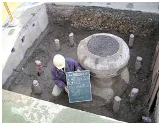
写真 マンホールに設置されたドレーン（アースドレーン工法協会による）
