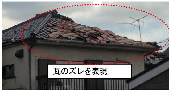
図2 実際の屋根被害（瓦のズレ）
