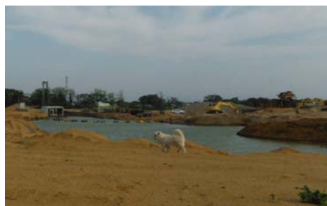
写真-1 砂利採取工事
