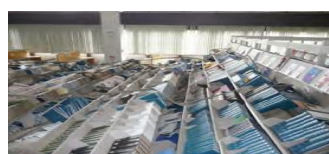
写真-1 東日本大震災における書架の転倒 4)
