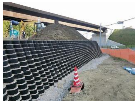
図-1 ジオセルの施工事例
