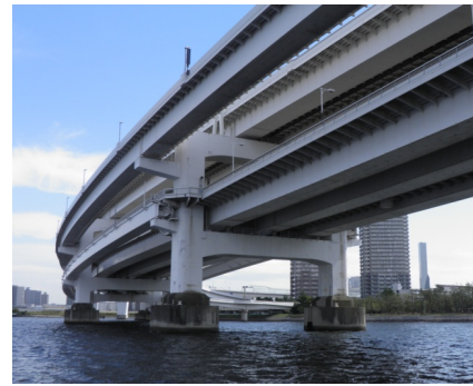
写真-2 P31 橋脚全景
