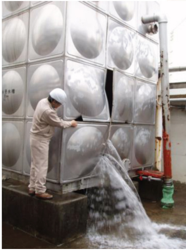
図-2(d) つくば市、受水槽、ステンレス製、1985年設置
