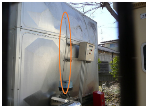
図-3 バルジングによるタンクの被害例 (福島県相馬市、受水槽、ステンレス製、2002年設置)
