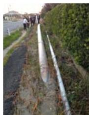
写真-5 管きよの被害
