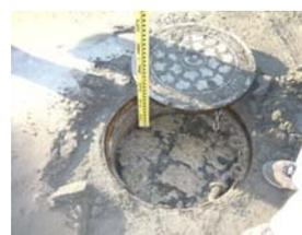
写真-3 マンホール土砂閉塞
