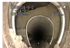
写真-1 本管継手の離脱
