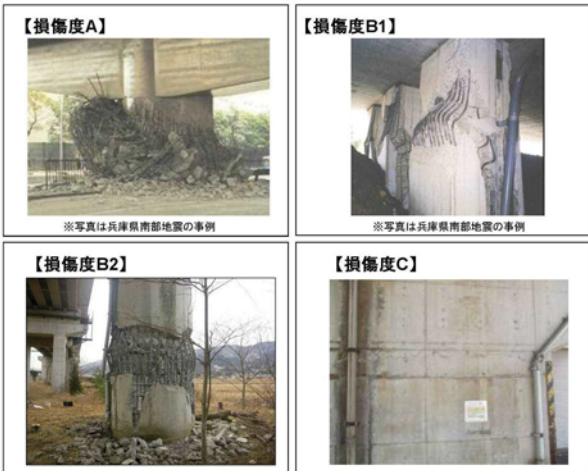
図-1 損傷度の判定区分の例
