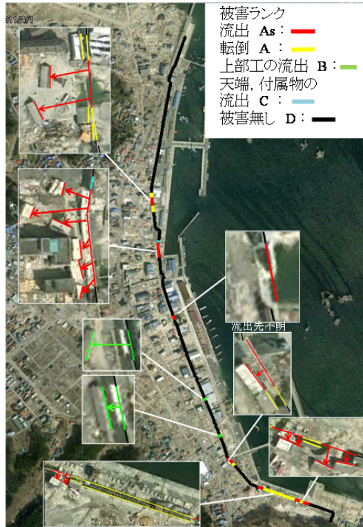
図-4 対象とする防潮堤の被害及び無被害の詳細
