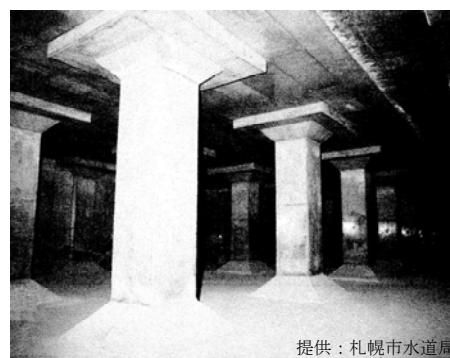
図-1 地下浄水池内部の状況
