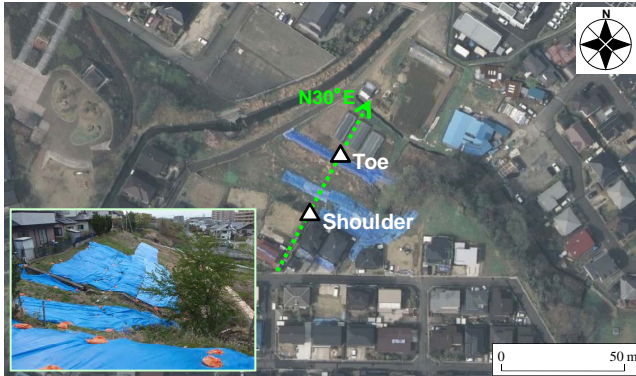
写真-1 2011年東北地方太平洋沖地震による対象斜面の被災 19)
