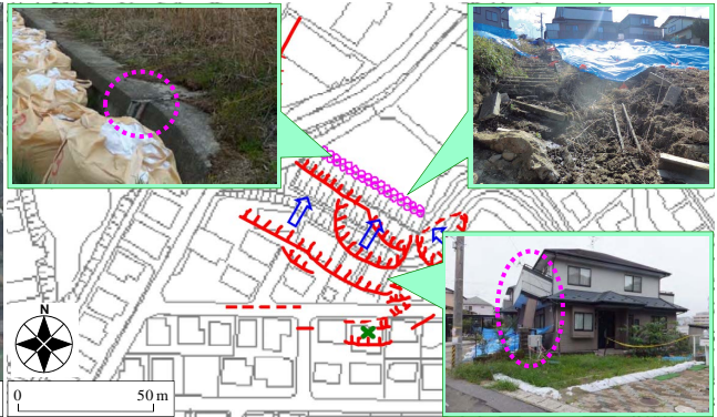
図-3 対象斜面の亀裂分布 3) と地震被災状況 19)
