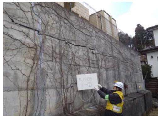
(b) 鉄筋コンクリート擁壁の横クラック被害
