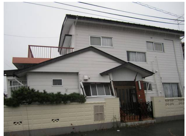
図-13 浪江町市街地の木造建物被災事例（被災度 D4） (2013年4月3日撮影)。
