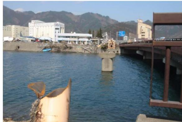
写真-1 津波来襲後の状況(左:下流側, 右:上流側水管橋の流出)
