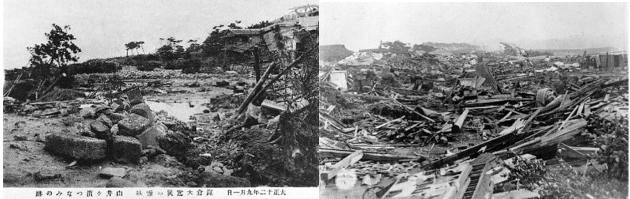
図-1 関東地震の津波による鎌倉市の被災状況 9) (左…由比ヶ浜地区 右…坂ノ下地区)
