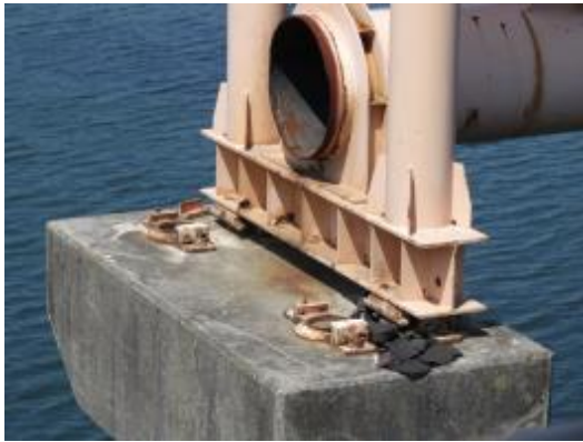
図-5 水管橋支承部(P-3)
