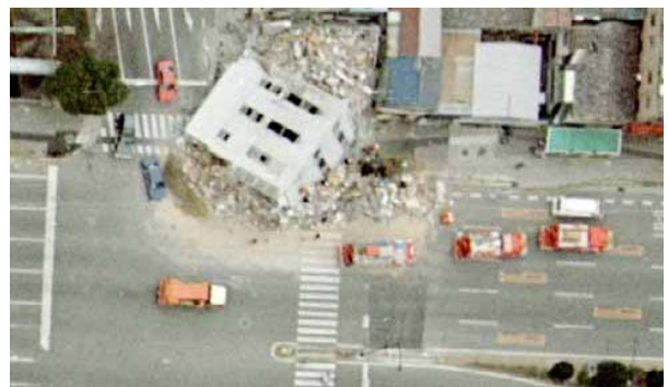
写真-1 幹線道路上のガレキの状況
